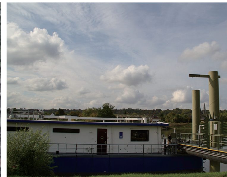
荷兰Eijsden监测站外貌
